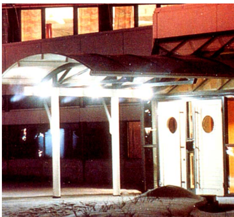
Iluminación de accesos exteriores
