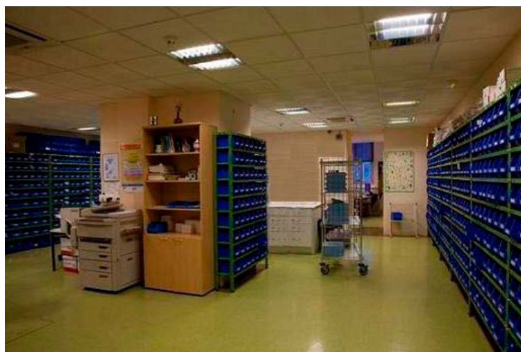
Iluminación de almacenes
